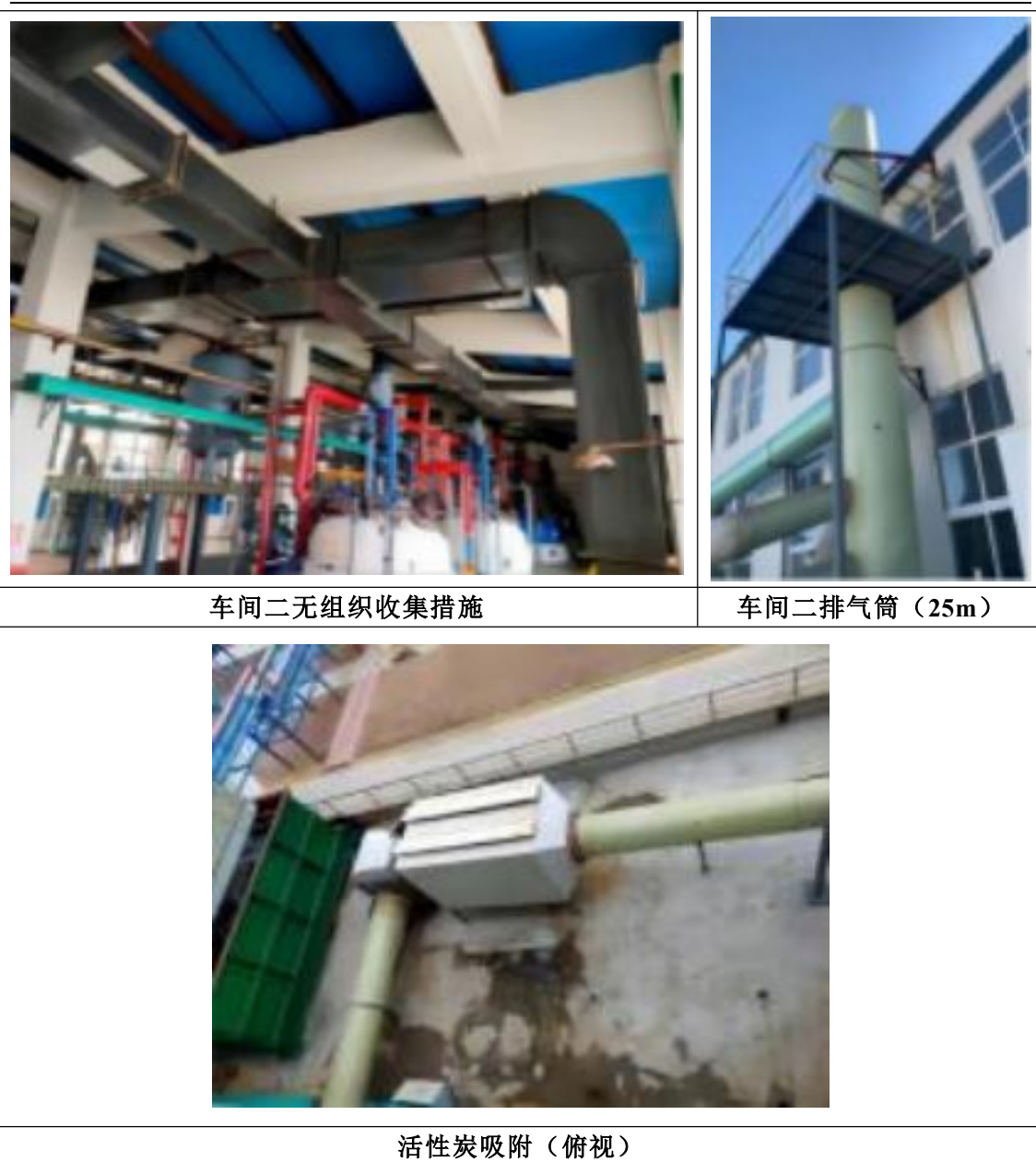
图 5.3-2 生产车间二废气治理措施图
