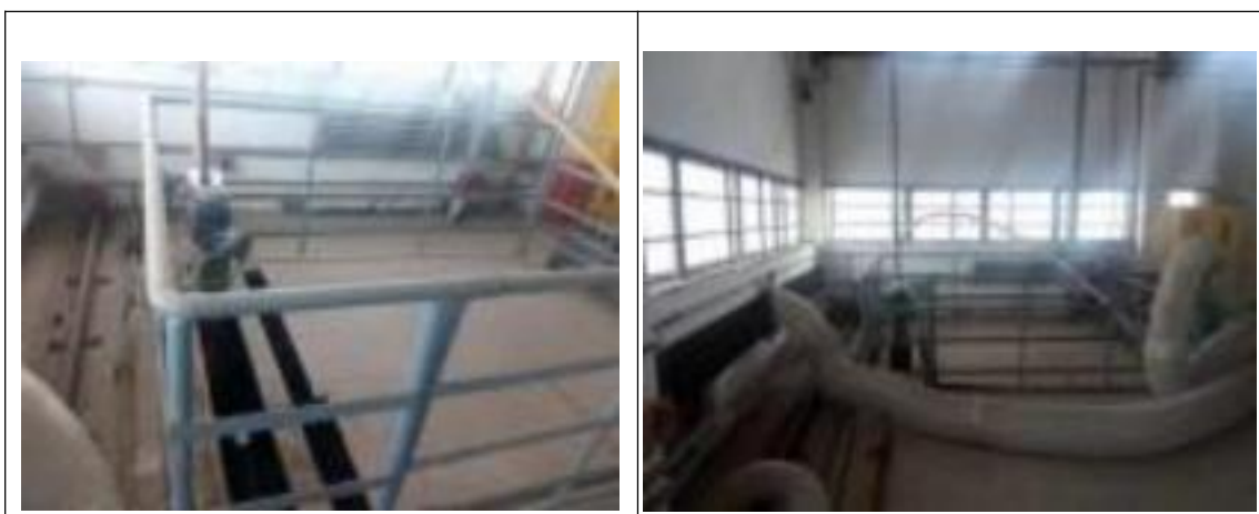
图 5.7-4 碱液应急池照片
