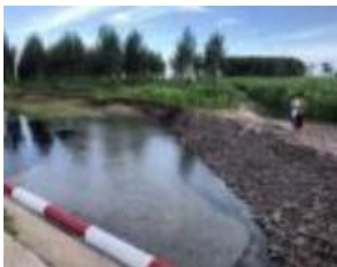
两家子镇红旗干沟凹岸冲刷严重
