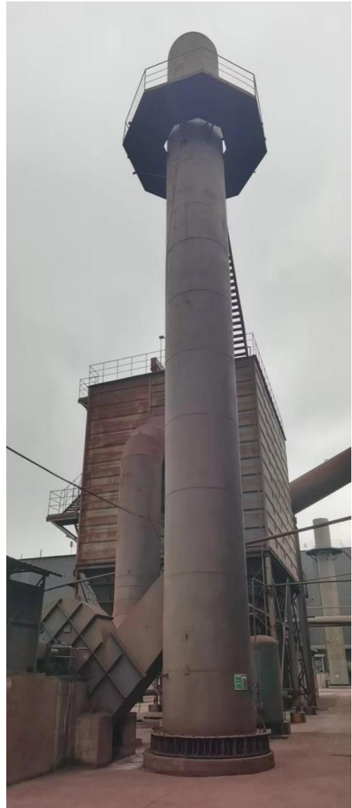
烧结机尾废气排气筒
