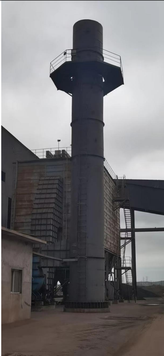
合金炉环境除尘废气排气筒
