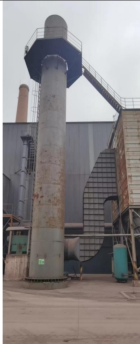
矿槽废气排气筒
