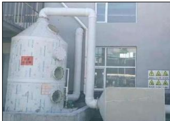
污水处理工程尾气处理系统
