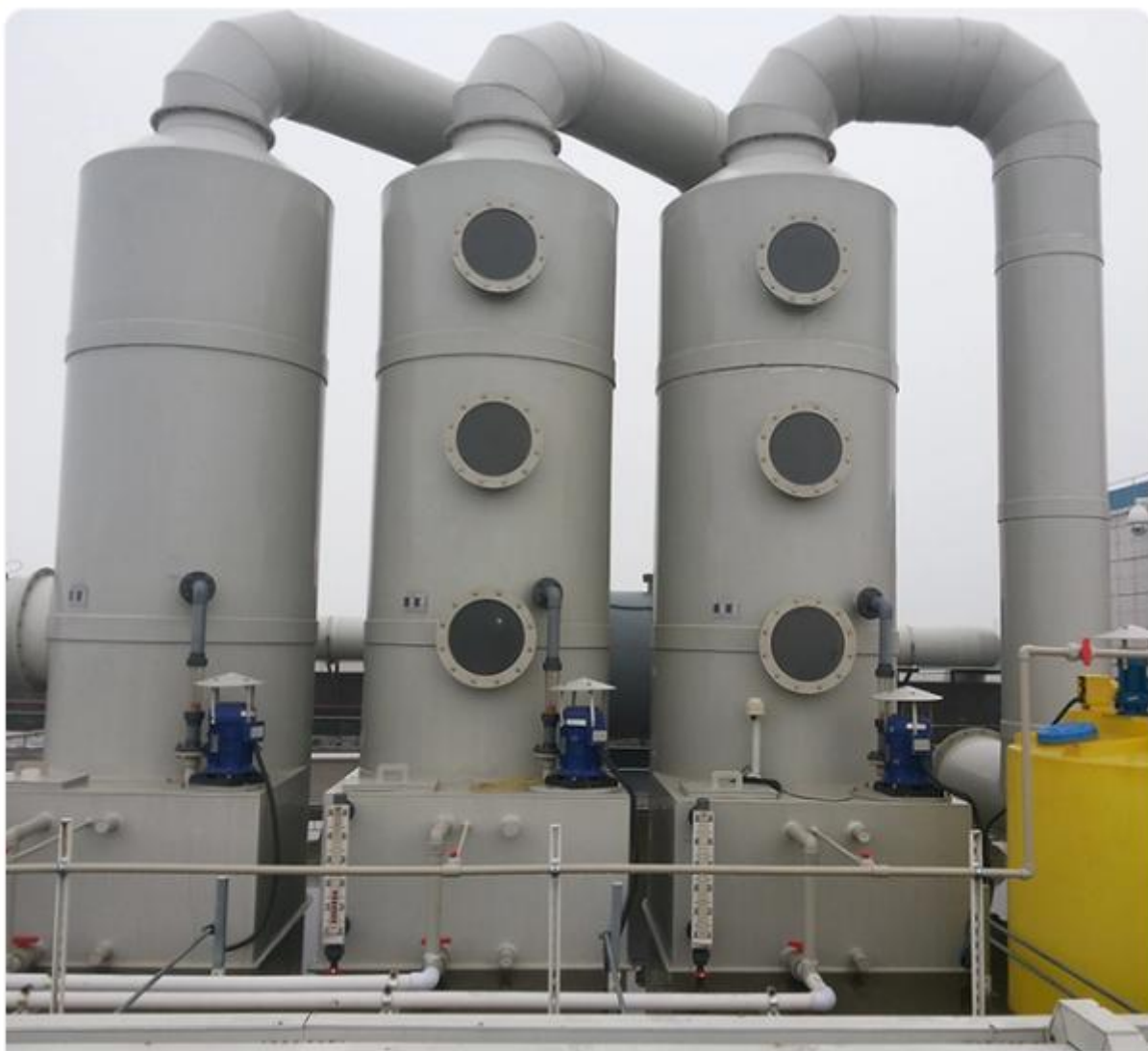
图 6.2-3 酸（碱）喷淋塔设备图
