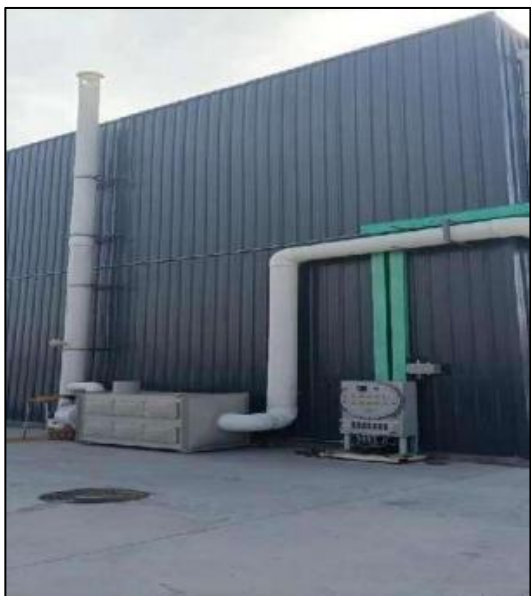
库房、危废贮存库尾气吸收系统及排气筒 (DA002)
