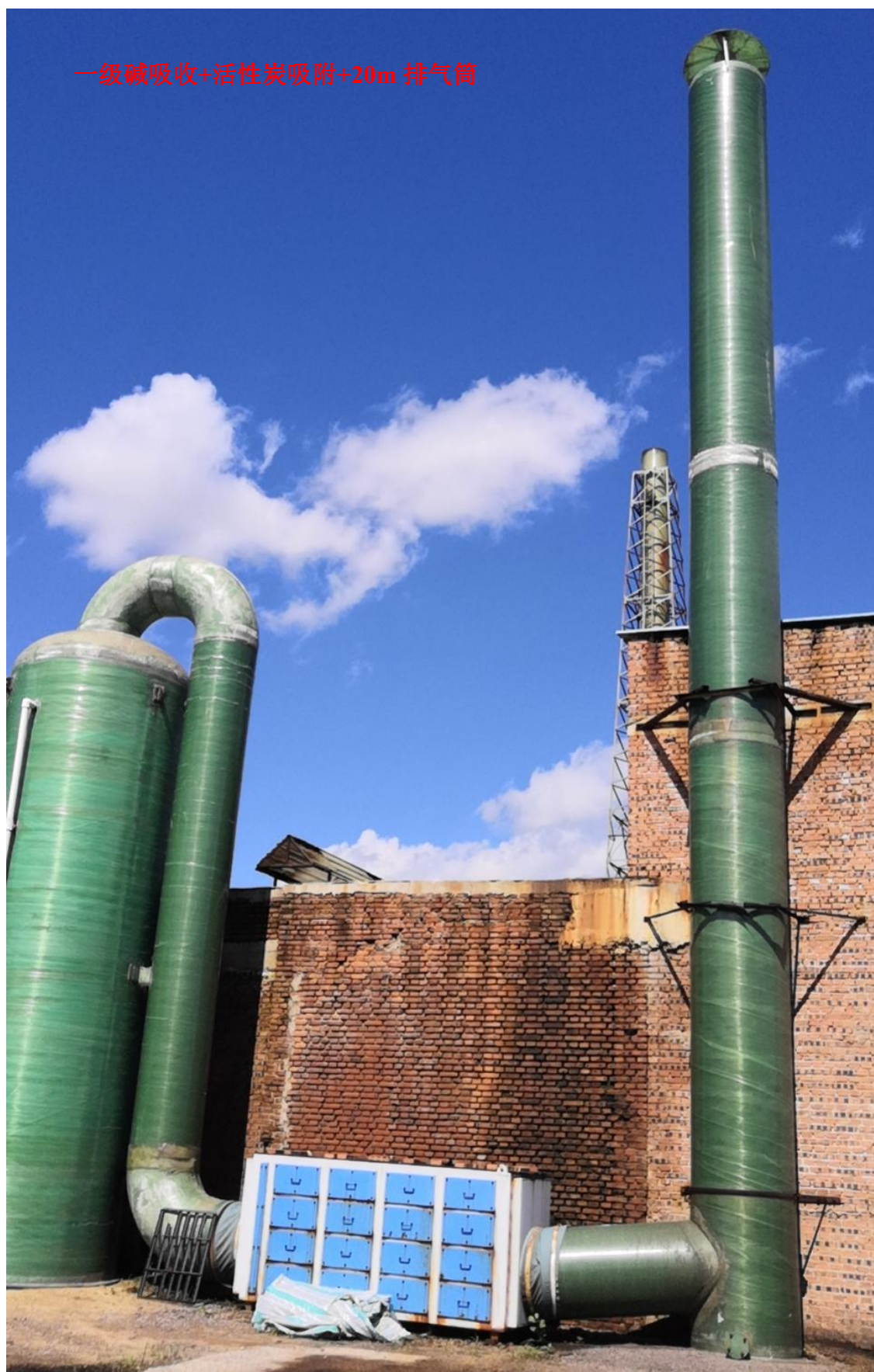
图5.1-1 废气环保设施图
