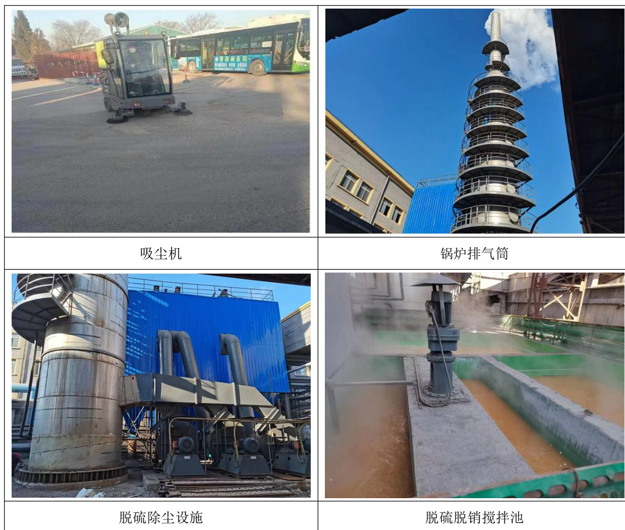
图2.3-1废气处理措施现场照片
