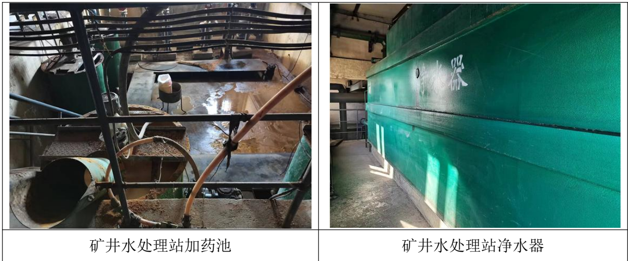
图2.3-2 矿井水污水处理站现场照片
