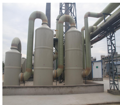
车间废气收集-洗涤-吸附处理 1
