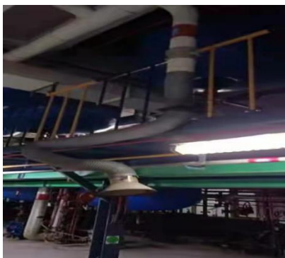
车间无组织废气收集罩
