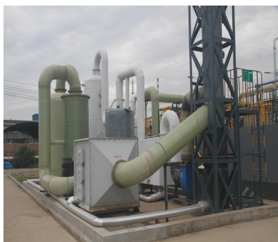
污水站废气处理装置
