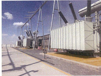
附图3 主变压器
